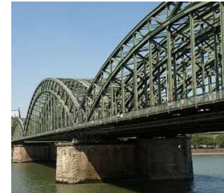
Puente de acero pintado
